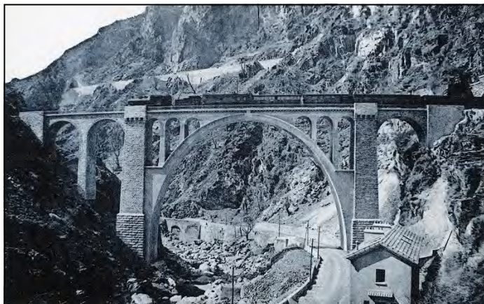
Il bel viadotto di Scarassù prima delle distruzioni di guerra (ora il ponte ha un aspetto completamente diverso)
