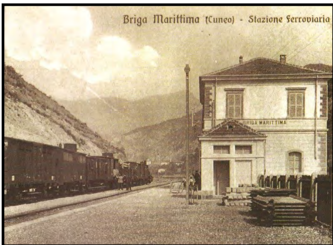
La stazione di Briga, ora ridotta a semplice fermata, col fabbricato viaggiatori non più utilizzato
